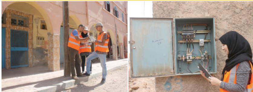
Diagnostic de l'éclairage public à Tata, Octobre 2017
