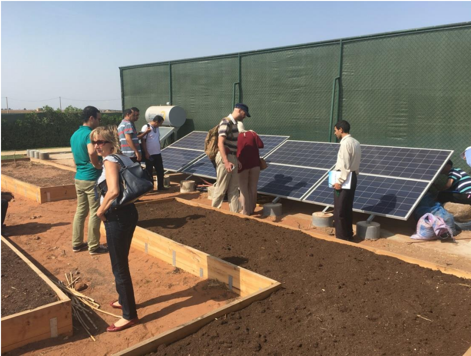
Photo 1: Visite d'une installation proche de Berrechid, 8 x modules 260Wc = 2080Wc, pompe LORENTZ PS2-1800 C SJ-5-12, HMT = 66m, débit journalier = 23m 3
