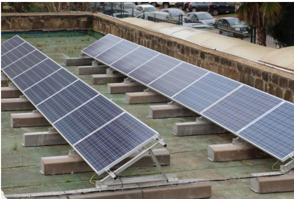
Installation PV sur le toit du MEMDD
