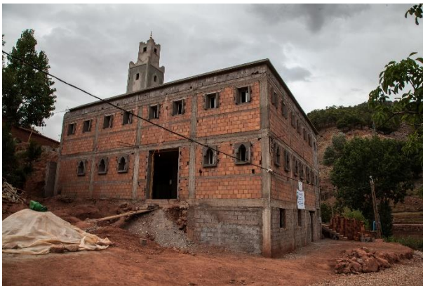
Pendant la construction
